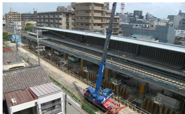
野江駅（仮称）工事の様子
