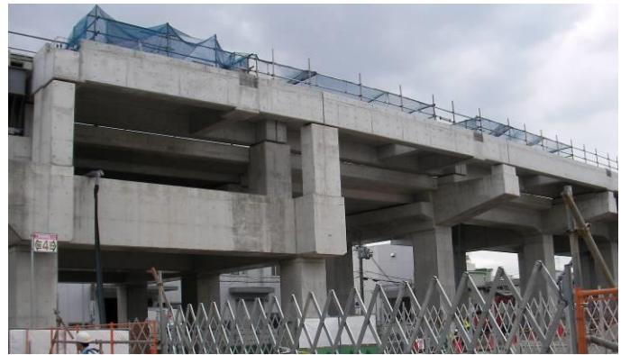
西吹田駅（仮称）工事の様子
