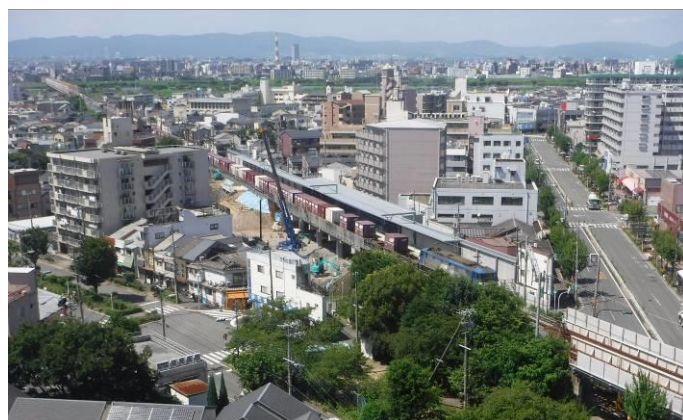
都島駅（仮称）工事の様子
