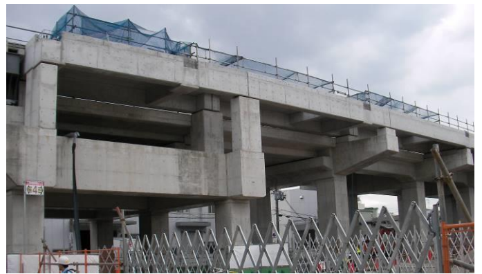
西吹田駅（仮称）工事の様子
