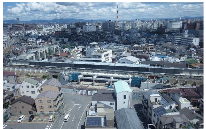
淡路駅（仮称）工事の様子
