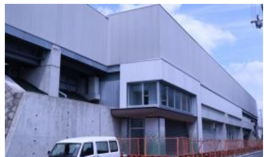
城北公園通駅 工事の様子
