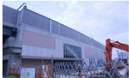
南吹田駅 工事の様子
