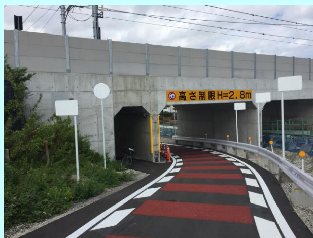
迂回仮道路（トンネル）
