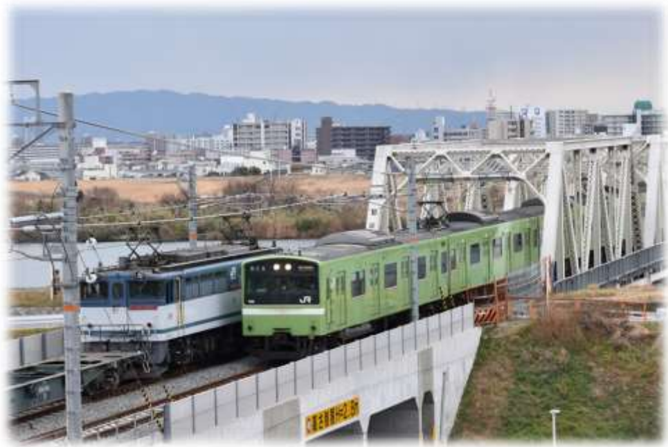
おおさか東線 淀川（赤川）橋りょう付近
